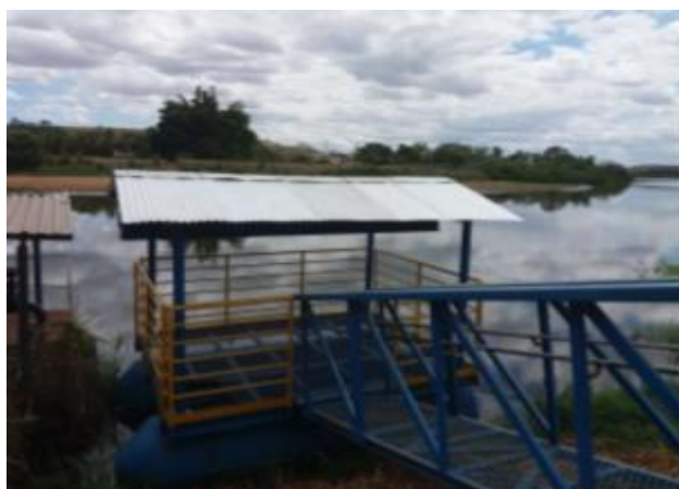
Figura 37 - Construção de nova balsa de captação.
