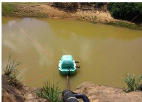
Figura 16 - Flutuante com duas bombas (1 reserva).
