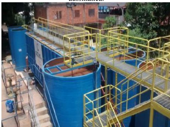
Figura 4 - Construção de nova ETA modular automática.
