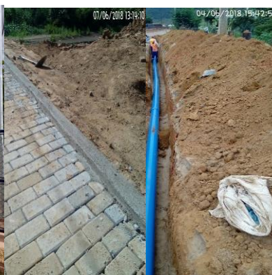
Figura 58 - Adutora (ligando os poços a nova EAB).
