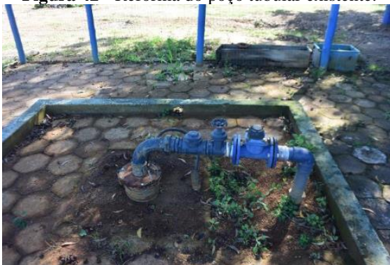
Figura 42 - Reforma do poço tubular existente.
