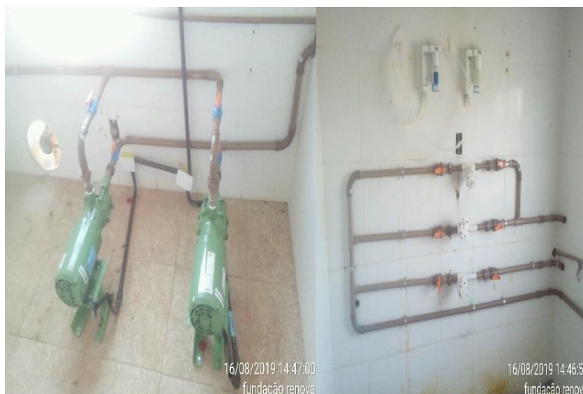
Figura 61 - Reforma do sistema de cloro gasoso.
