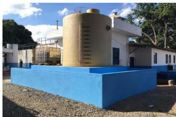
Figura 7 - Construção de contenção de químicos.
