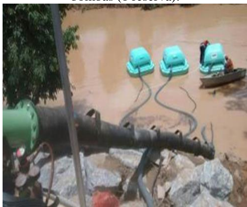
Figura 18 - Três conjuntos de flutuantes com duas bombas (1 reserva).
