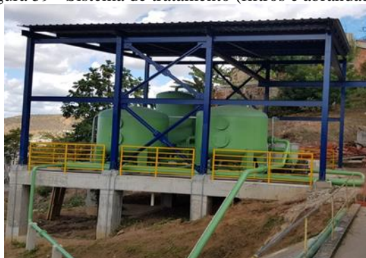
Figura 59 - Sistema de tratamento (filtros e abrandador).
