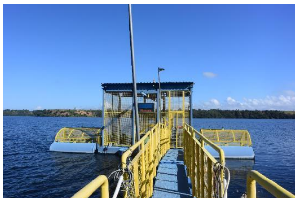
Figura 40 - Balsa com 3 bombas, sendo 1 reserva.
