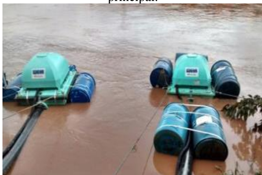
Figura 10 - Instalação dos flutuantes na captação principal.
