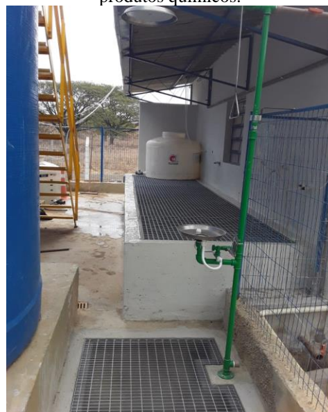
Figura 36 - Construção de contenção para produtos químicos.
