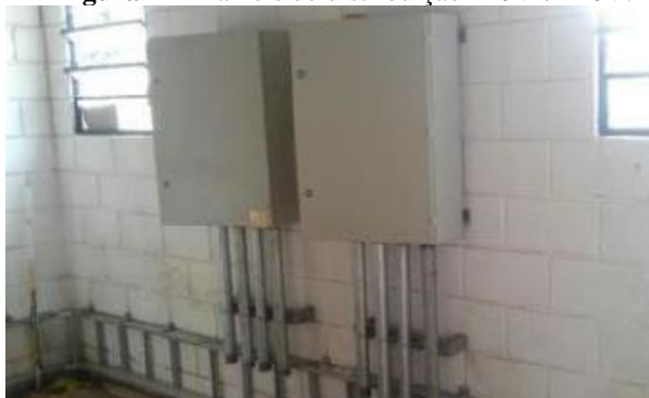
Figura 12 - Painéis de distribuição 220V e 440V.
