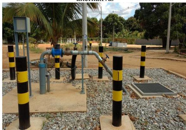
Figura 23 - Poços instrumentados como captação alternativa.
