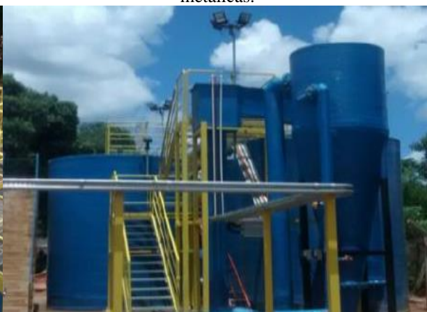
Figura 5 - Nova ETA modular e melhorias estruturais metálicas.
