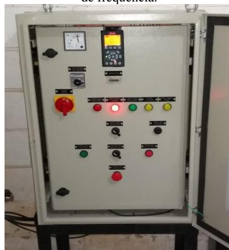
Figura 15 - Painel de acionamento com inversor de frequência.
